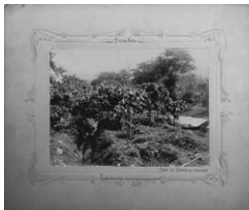
74 RAUL DE SOUSA. - Trabalhos de Drenagem do Pantano Junto ao Terreiro – S. Tomé – Roça Bella Vista. 220x160 mm.
